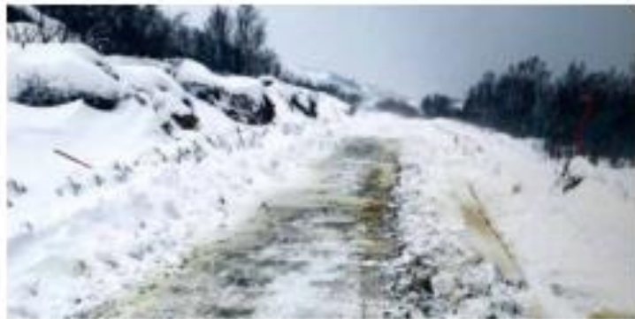
Etterslepet på fylkesveier i 2020 • En av mange godkjente forprosjektene i etterslepplanen for fylkesveier i 2020. Bildet er fra et av de mange forprosjektene som er godkjente i etterslepplanen for fylkesveier i 2020. Bildet er fra et av de mange forprosjektene som er godkjente i etterslepplanen for fylkesveier i 2020.
