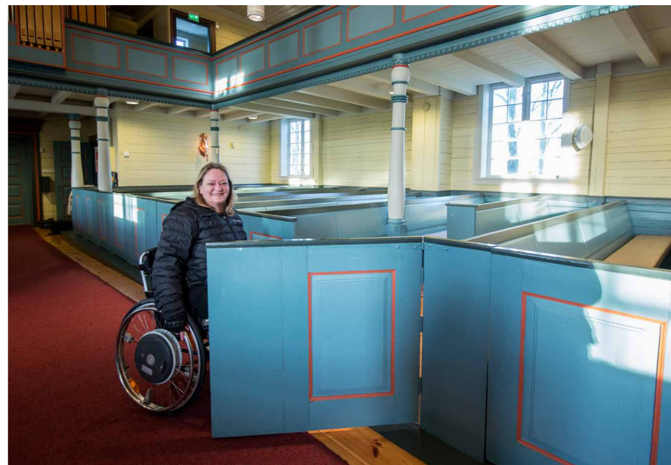
BRED NOK: Døren ble spleiset med sidepanelet, og ble dermed bred nok til rullestolen til Sissel Løchen – uten å ødelegge det visuelle uttrykket. (Foto: Fredrik Naumann/Felix Features).
