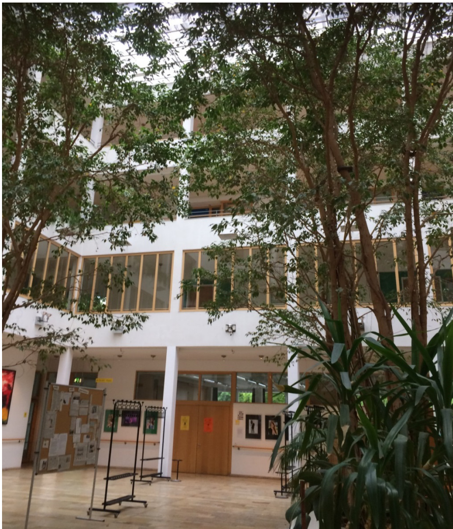
Glassatriet i flergenerasjonshuset. Svalganger rundt med selvstendige leiligheter.
