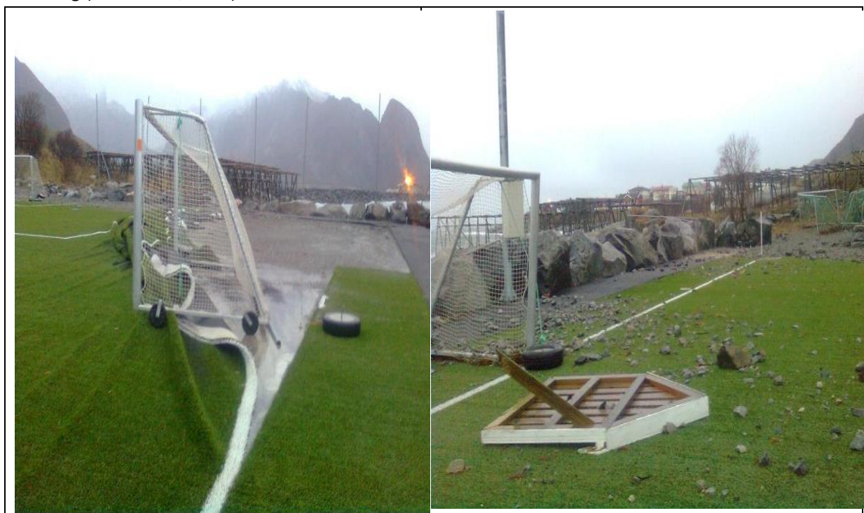
Figur 37 Skade på den kommunale idrettsbanen i Moskenes 22
