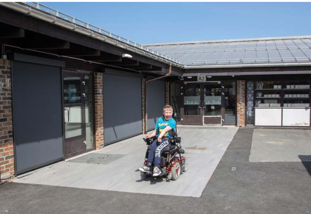
NULL PROBLEM: Med varmekabler helt fra drosjeholdeplassen og frem til inngangspartiene er det en smal sak for Magnus og de andre å ta seg frem på vinteren. Om sommeren trenger man ikke bekymre seg for den slags. (Foto: Fredrik Naumann/Felix Features).
