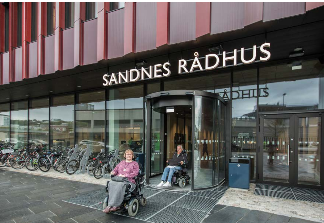
HOVEDINNGANG FOR ALLE: Skyvedører i sluse – og med kontrastfelt – passer for alle brukere, samme om man har dårlig syn, er dårlig til beins eller bruker hjul. (Foto: Fredrik Naumann/Felix Features).
