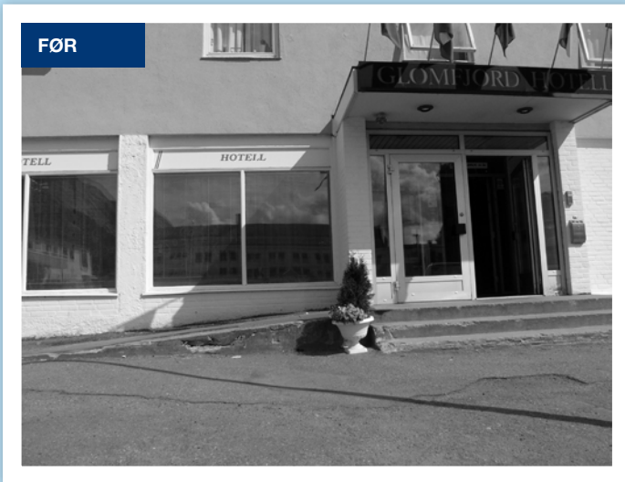
FØR: Den gamle inngangen til Glomfjord Hotell med rampe og trapp.
