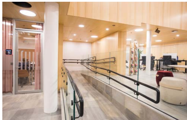
RAMPEADKOMST: En halv etasje ned fra service-senteret til Folkeforumet kan løses ved å ta rampe eller heis. (Foto: Fredrik Naumann/Felix Features).
