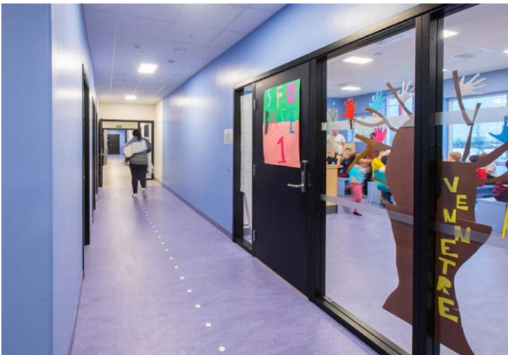
FINE GREP: God fremkommelighet med fritt gangareal og tydelig kontrast mellom dør og veggfarge. Den etterlysende gulvmarkeringen er ledelinje for rømningsvei. (Foto: Fredrik Naumann/Felix Features)
