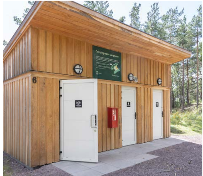
FLERE ANLEGG: På Langøyene utenfor Oslo er det flere nye toalettanlegg.
