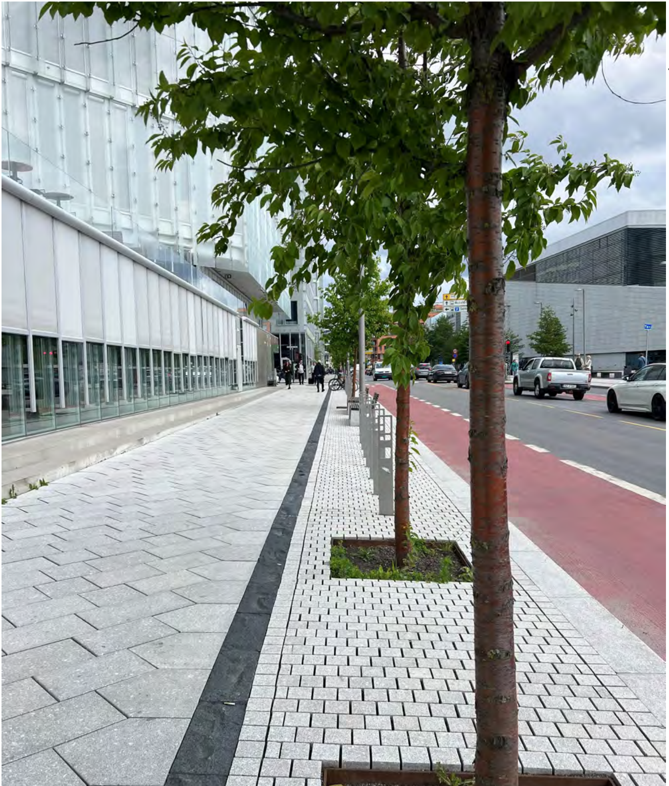
Rød farge markerer sykkelfeltet og mørk kantlinje markerer overgang mellom møbleringssone og gangareal.
