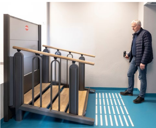
SMART LØSNING: Ett trykk på knappen, og vips, så er trappen forvandlet til en rullestolrampe. Trond Henning Klausen demonstrerer.
