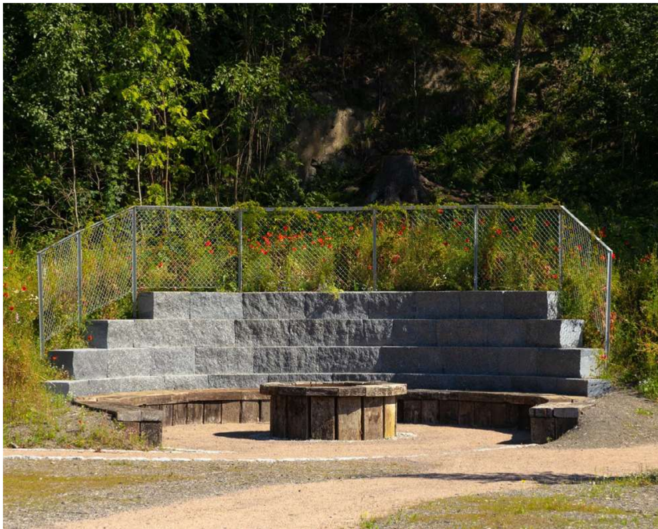
Grillplass med fast trillevennlig underlag og trinnfri adkomst. Foto: Monika Dadwal
